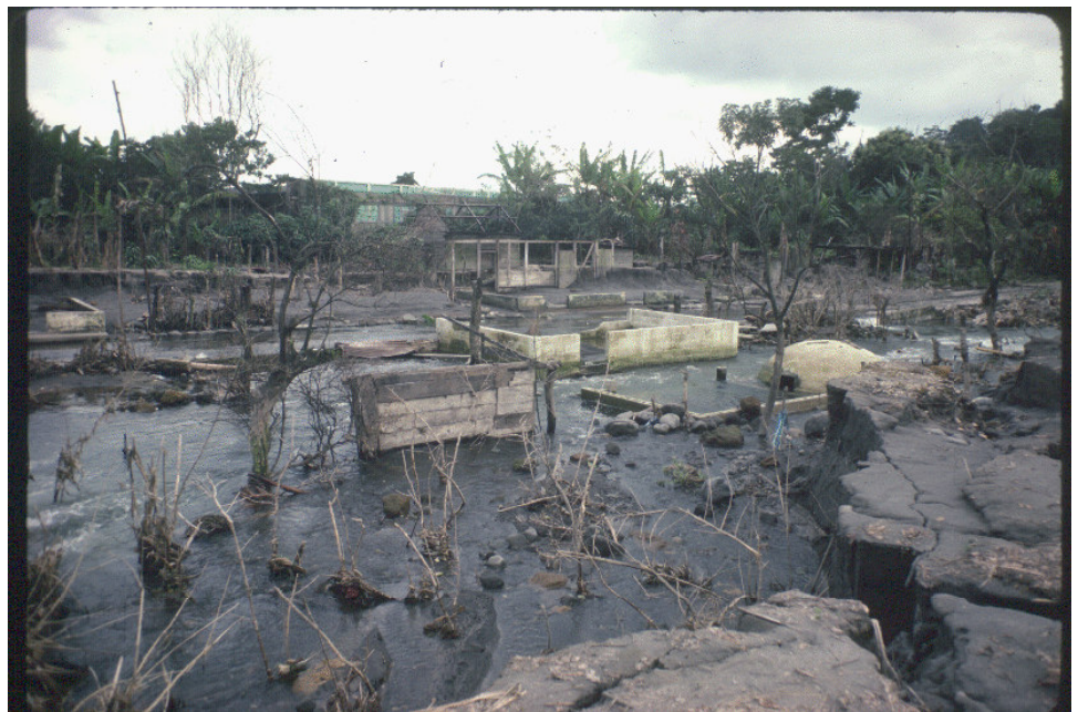
Figura 11. Aspecto del daño causado en la población de El Palmar en 1983. Fotografía tomada por Bill Rose.
