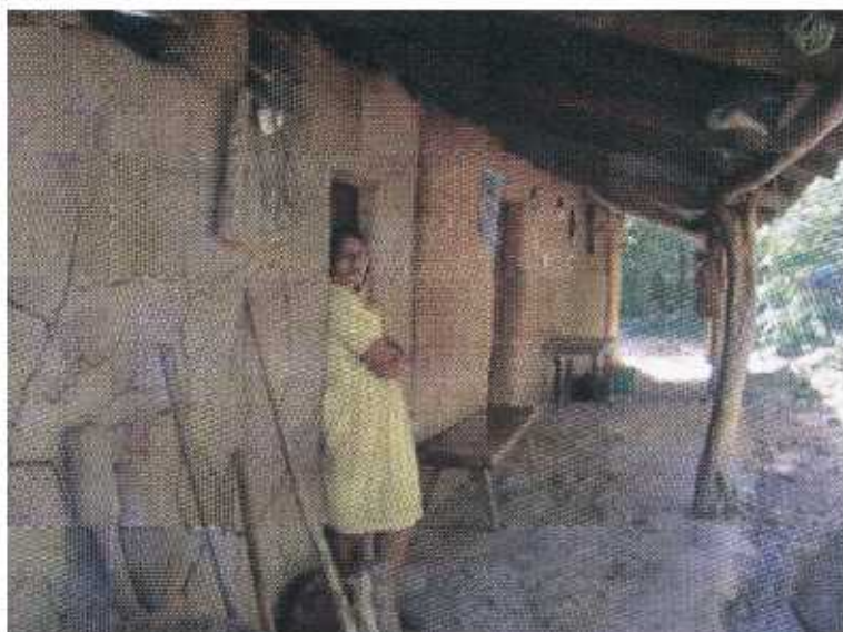
Fotografía de una vivienda tradicional con paredes de bajareque y techo de teja, con alta vulnerabilidad a terremotos.
