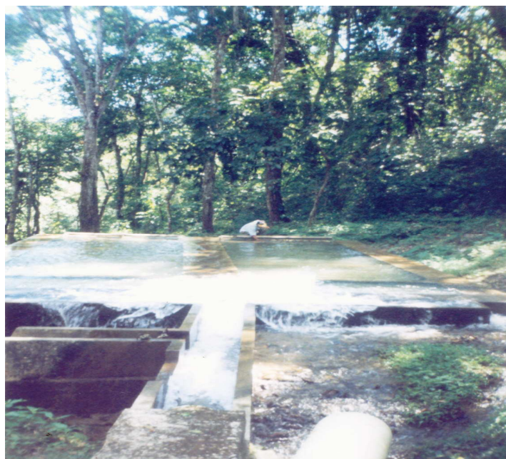
Figura 14. Desarenador del sistema del abastecimiento de agua potable del municipio de Gualán, Zacapa
