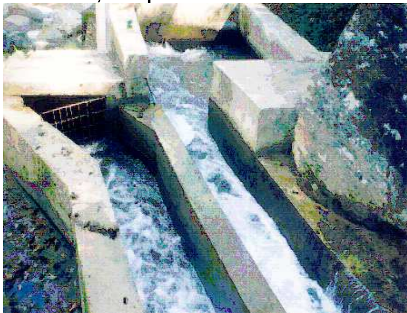
Figura 13. Canal de alivio, más canal de captación del sistema de abastecimiento de agua potable del municipio de Gualán, Zacapa
