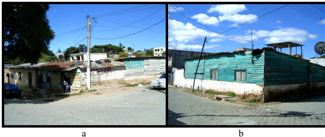
Figura 21. Ejemplos de problemas típicos observados en estructuras de madera.
