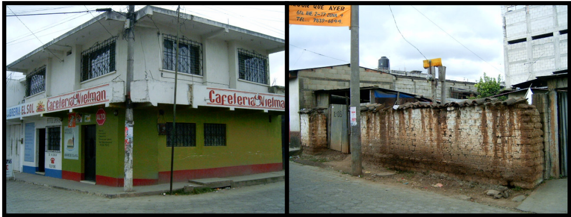
Figura 9. Fotografías mostrando la tipología estructural del sector estudiado. a) Construcción residencial-comercial de mampostería media de bloque (evaluación # 776), b) Construcción de mampostería no reforzada de adobe (evaluación # 753), c) Construcción de madera (evaluación # 176), d) Construcción comercial de Acero (evaluación # 749).
