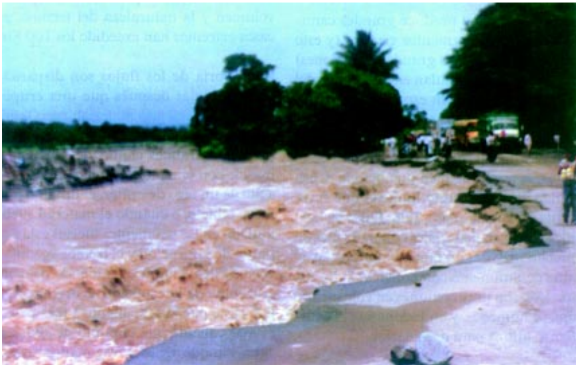
Brazo del río Samalá que destruyó un tramo de 40 metros de la carretera CA-2, Km. 176.5, puente El Niño. (Lahar categoría 4, del 28 de agosto de 1993) La fractura llegó hasta la línea media de la carretera
