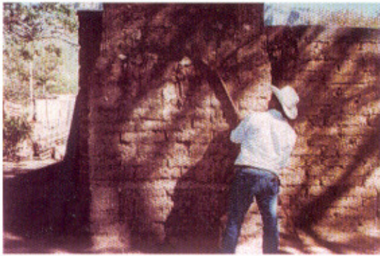
Emparejado de muro
