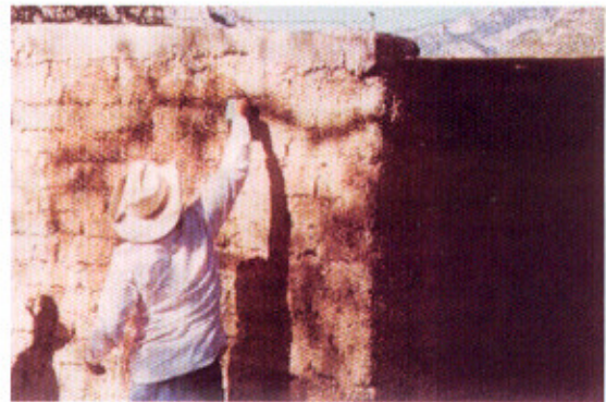
Aplanado de mortero
