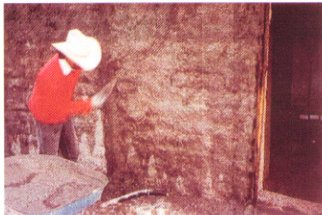
Aplicación de aplanado de mortero
