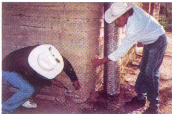
Fijación de la malla
