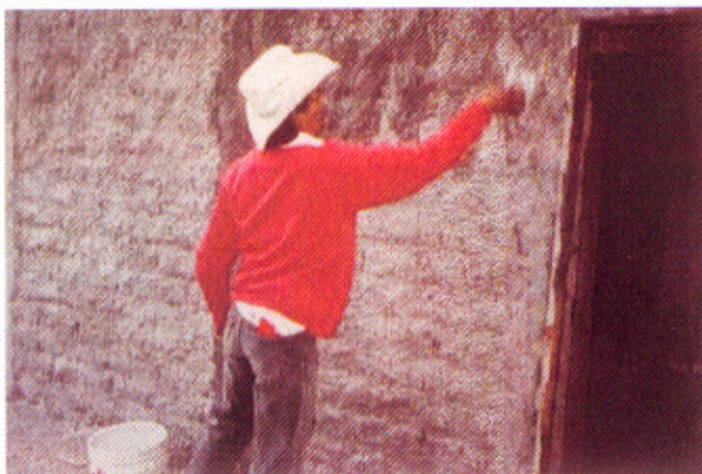
Aplicación de aplanado de mortero
