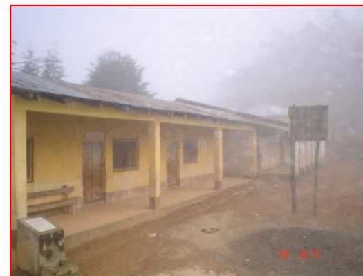
FOTOGRAFIA 1 Módulo de Aulas y Cancha Deportiva.
