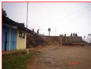
FOTOGRAFIA 1 Escuela y Cancha Deportiva.
