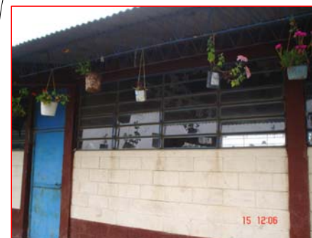
FOTOGRAFIA 3 Se observa buen estado en los muros y puertas, se deben reponer vidrios de las ventanas.
