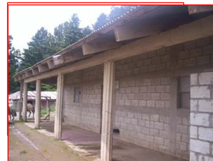
FOTOGRAFIA 3 Módulo de aulas de block visto, cubierta de madera y lámina en mal estado.
