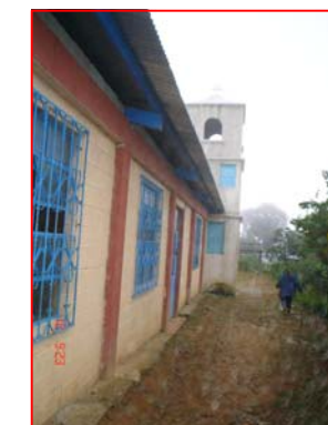
FOTOGRAFIA 3 Vista lateral de la Iglesia
