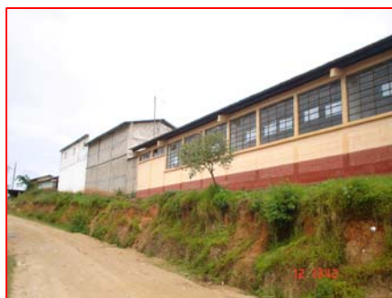
FOTOGRAFIA 4 Vista lateral de Módulo de Aulas habilitadas.
