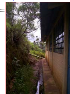
FOTOGRAFIA 3 Se observa drenaje de agua pluvial visto.
