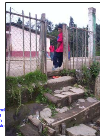
FOTOGRAFIA 3 Circulación de malla en muy mal estado, debe reemplazarse, ya que detras de esta área existe un desnivel de más de 10.00mts. Aquí se observa a un alumno tratando de subir después de ir tras el balón con el que jugaban en la cancha deportiva.
