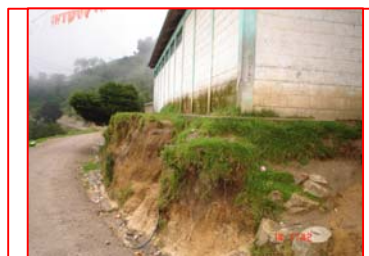
FOTOGRAFÍA 1 Calle de terracería en buen estado, aledaña a la Escuela, se observa ausencia de aceras o caminamientos, lo cual constituye un riesgo para los peatones. Talud sin tratamiento.
