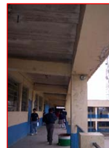
FOTOGRAFIA 6 Se observa humedad en la cubierta de lámina de asbesto. Desprendimiento en repello y pintura, debido a la humedad. Necesidad de mantenimiento, limpieza y pintura.
