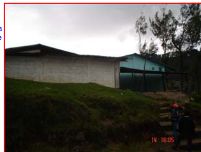
FOTOGRAFIA 2 Ingres a Escuela, se recomienda realizar muro de contención en el corte del terreno.
