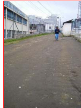
FOTOGRAFÍA 1 Calle de terracería adyacente a la Escuela, se observa ausencia de aceras o caminamientos. lo cual constituye un riesgo para los peatones.
