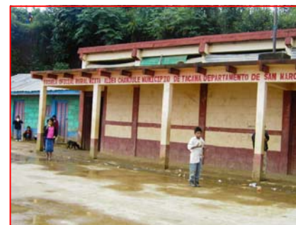
FOTOGRAFIA 1 Módulo de Aulas contiguo a Cancha Deportiva, se observa humedad en la base de los muros.
