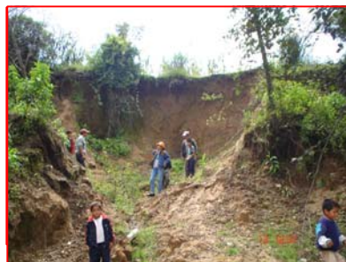
FOTOGRAFIA 4 Deslizamiento ocurrido durante la Tormenta Stan.
