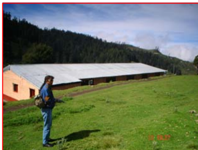
FOTOGRAFIA 1 Cubierta de láminas en buen estado.
