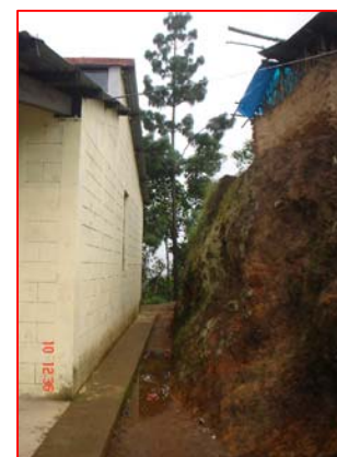
FOTOGRAFIA 3 Corte del Terreno sin tratamiento.
