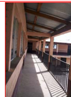
FOTOGRAFIA 1 Corredo r y baranda en buen estado.
