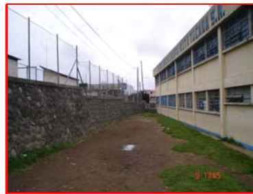
FOTOGRAFIA 2 Talud con tratamiento en piedra y muro perimetral de malla en buen estado, ventanería necesita reemplazo de algunos vidrios rotos y limpieza, falta de tratamiento y mantenimiento en áreas verdes.
