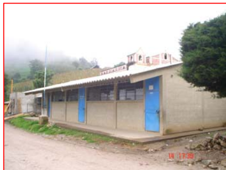
FOTOGRAFIA 4 Módulo de Aulas de reciente construcción. Block visto, se observa humedad en base de muros, así como falta de tratamiento de áreas verdes.
