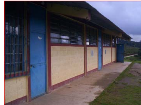
FOTOGRAFIA 3 Módulo de aulas en buen estado.
