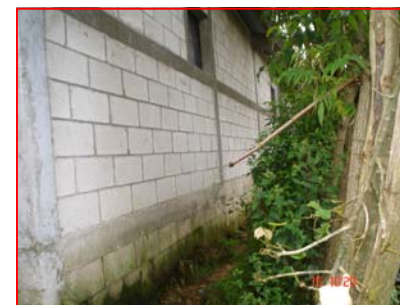
FOTOGRAFIA 3 Muro de Módulo de Aulas, en mal estado, se observa humedad.
