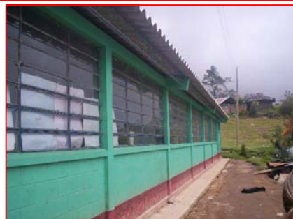
FOTOGRAFIA 1 Módulo de Aulas, en buen estado.
