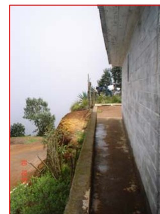
FOTOGRAFIA 4 Corte del terreno sin tratamiento.
