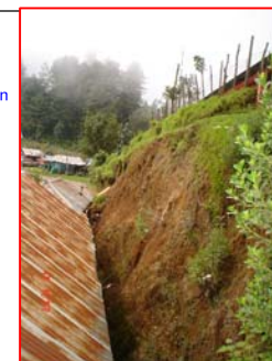
FOTOGRAFIA 6 Cortes del terreno sin tratamiento.
