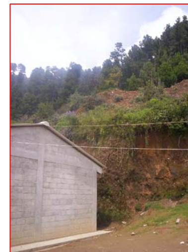
FOTOGRAFIA 3 Vista lateral de módulo de aulas, se observa el corte del terreno sin tratamiento.
