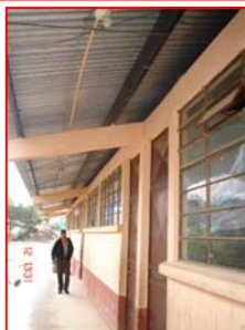
FOTOGRAFIA 2 Módulo de Aulas.
