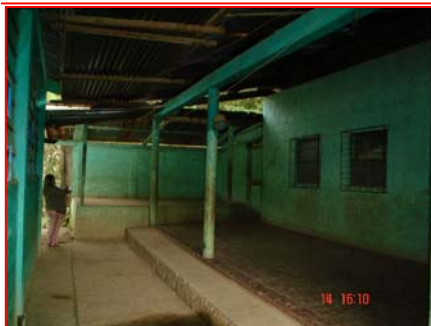
FOTOGRAFIA 1 Se observan instalaciones eléctricas expuestas, láminas en mal estado y deterioro en la pintura de los muros.
