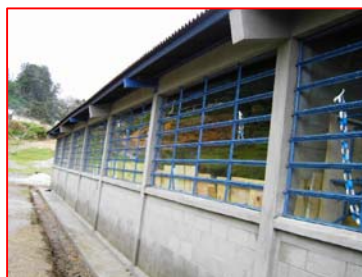
FOTOGRAFIA 5 Ventaneria en buen estado, se observa humedad en la base de los muros, los cuales requieren recubrimiento.
