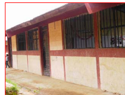
FOTOGRAFIA 2 Módulo de Aulas, se observan muros en buen estado, la estructura portante de techo es de madera y necesita reparaciones, así como la lámina de la cubierta.
