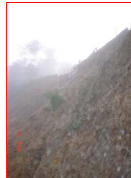
FOTOGRAFÍA 2 Cortes del terreno, sin tratamiento.
