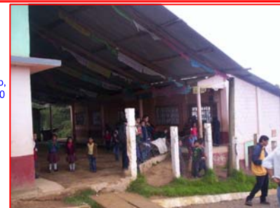
FOTOGRAFIA 3 Patio de tierra, aledaño a módulo de aulas.
