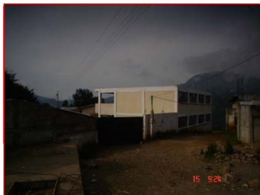
FOTOGRAFIA 2 Vista de Escuela y calle de terracería.
