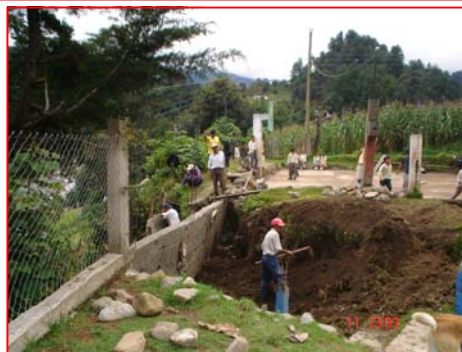
FOTOGRAFIA 2 Trabajos de mitigación en Escuela Primaria
