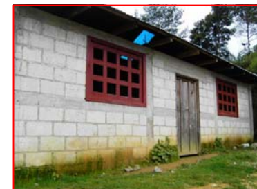
FOTOGRAFIA 6 Salón de clases de block visto, el cual presenta humedad en la base de los muros, puerta de madera deteriorada y láminas de cubierta en mal estado.
