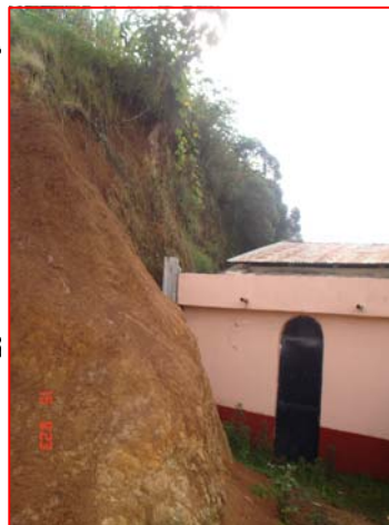
FOTOGRAFÍA 2 Corte del Terreno, sin tratamiento, aledaño a Iglesia Católica.
