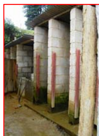
FOTOGRAFIA 5 Letrinas en mal estado, se observa humeda, ausencia de puertas y en general muy mala higiene.
