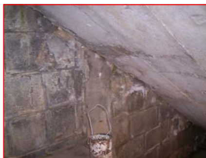
FOTOGRAFIA 2 Humedad y salitre en muro debajo del módulo de gradas.
