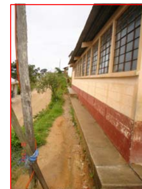
FOTOGRAFIA 6 Vista lateral de Módulo de Aulas, se observa corte del terreno sin tratamiento.
