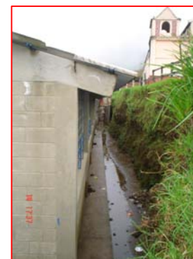
FOTOGRAFIA 1 Corte del terreno aledaño a Módulo de Aulas, se observa lámina de cubierta de techo en mal estado.
