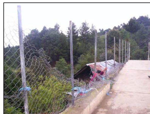
FOTOGRAFIA 3 Circulación de malla en muy mal estado, debe reemplazarse, ya que detras de esta área existe un desnivel de más de 10.00mts. Aquí se observa a un alumno tratando de subir después de ir tras el balón con el que jugaban en la cancha deportiva.
