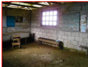
FOTOGRAFIA 2 Salón de clase con piso de tierra, se observa humedad en la base de los muros de block visto.
