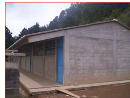
FOTOGRAFIA 2 Módulo de Aulas nuevo.
