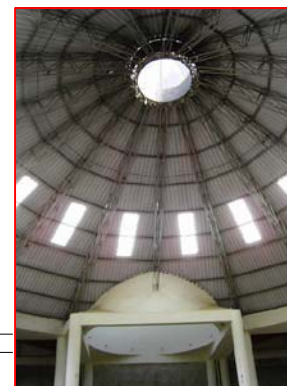
FOTOGRAFIA 2 Estructura de cúpula principal de la iglesia.
