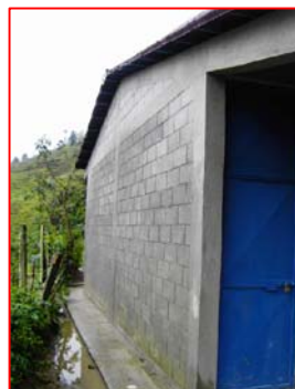
FOTOGRAFIA 4 Vista lateral de Módulo de Aulas, se observa humedad en la base de los muros.
