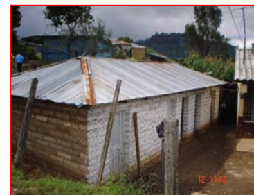
FOTOGRAFIA 1 Cocina y dormitorio de docente, construcción de adobe con humedad y deterioro estructural.
