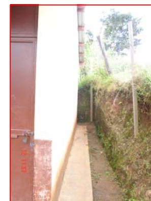
FOTOGRAFIA 6 Muro lateral de Módulo de Aulas, corte del terreno sin tratamiento.
