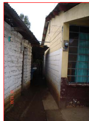
FOTOGRAFIA 3 Cocina y dormitorio de docente con humedad en las bases de los muros de adobe.
