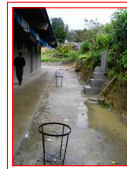
FOTOGRAFIA 3 Corte del terreno, con siembra de árboles, se sugiere mayor tratamiento, con un muro de contención.
