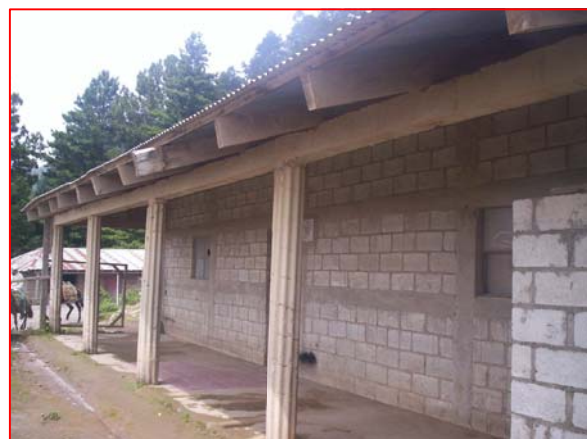
FOTOGRAFIA 2 Muros de block visto, se recomienda impermeabilizarlos con pintura o repello, la madera de la estructura portante del techo está en mal estado, al igual que las láminas de la cubierta.
