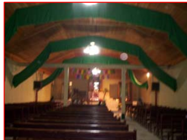
FOTOGRAFIA 2 Interior de la Iglesia, se observan: el altar y el área de bancas, se observa columnas y vigas que no responden al diseño de la estructura.
