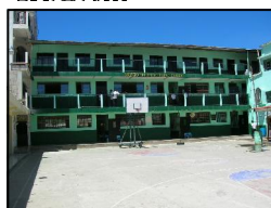
FOTOGRAFIA 01 INGRESO A EDIFICIO
