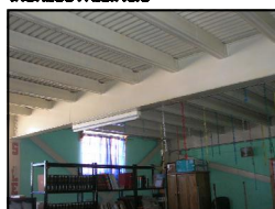
FOTOGRAFIA 04 ESTRUCTURA METALICA DE BIBLIOTECA
