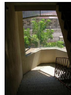
FOTOGRAFIA 3 DUCTO DE GRADAS
