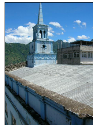
FOTOGRAFIA 02 CUBIERTA DE IGLESIA
