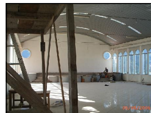
FOTOGRAFIA 04 SALON PRINCIPAL (FINALIZANDO CONSTRUCCION)
