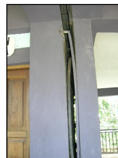
FOTOGRAFIA 04 CUBIERTA DE GRADAS
