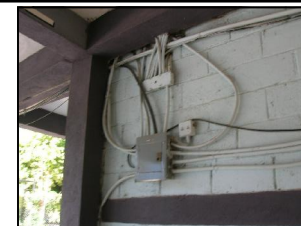
FOTOGRAFIA 01 INSTALACIONES ELÉCTRICAS EXPUESTAS
