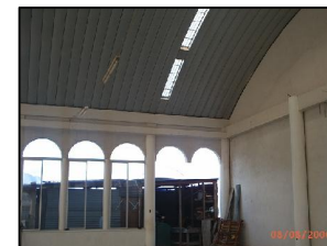
FOTOGRAFIA 05 AREA DE SALON SIN TERMINAR
