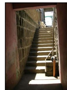
FOTOGRAFIA 04 INGRESO A EDIFICIO
