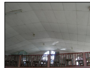
FOTOGRAFIA 07 MEZZANINE Y CIELO FALSO DE SALON PRINCIPAL
