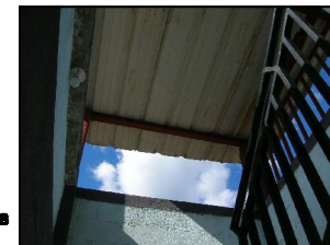
FOTOGRAFIA 05 SALON DE USOS MÚLTIPLES NIVEL 4
