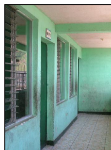
FOTOGRAFIA 02 PASILLO DE ALAS
