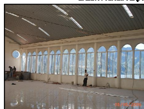
FOTOGRAFIA 07 VENTANAL SALON PRINCIPAL
