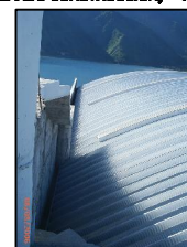
FOTOGRAFIA 08 CUBIERTA DE SALON PRINCIPAL
