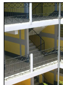
FOTOGRAFIA 06 DUCTO DE GRADAS
