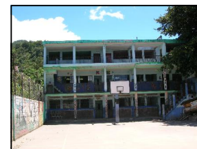
FOTOGRAFIA 01 VISTA DESDE INGRESO A EDIFICIO
