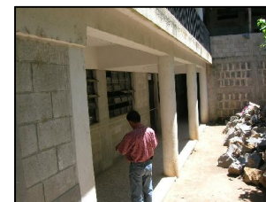
FOTOGRAFIA 01 INGRESO A EDIFICACION
