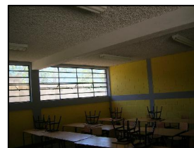
FOTOGRAFIA 04 INTERIOR DE AULAS
