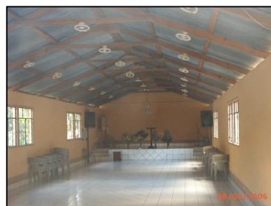
FOTOGRAFIA 02 INTERIOR DEL EDIFICIO
