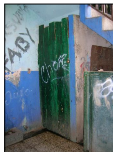
FOTOGRAFIA 07 BAÑO CON FUGAS
