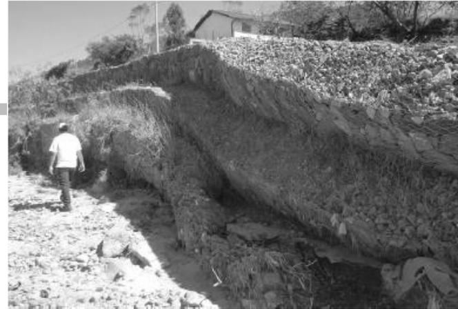
Gaviones del cauce del Río que se voltearon por socavación de su cimiento.
