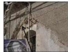
DESPRENDIMIENTO DE MATERIAL
