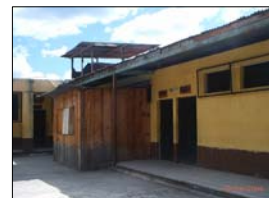
VISTA DE SERVICIOS SANITARIOS
