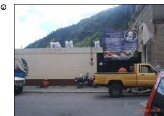
VISTA HACIA INGRESO
