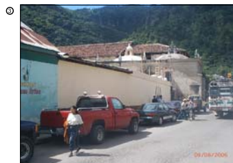
VISTA SOBRE CALLE PRINCIPAL
