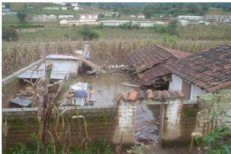
Foto 47 Estructura de la vivienda sector D
