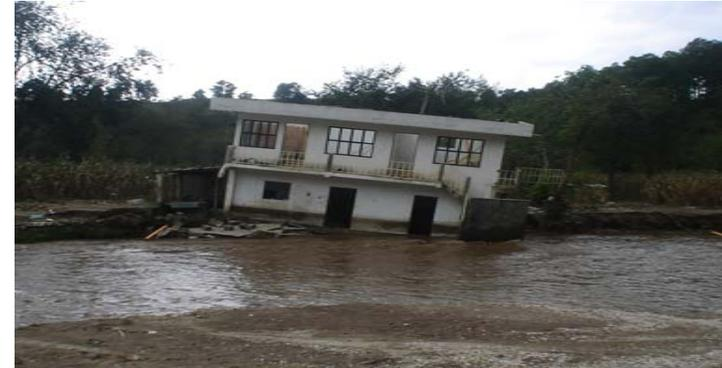
Muchas viviendas quedaron inhabilitadas por haberse construido a orillas río, como se muestra en las dos fotografías arriba y abajo, respectivamente. Sus cimientos fueron socavados por la fuerza del paso del río y eso produjo rajaduras en los muros principales de su estructura.
