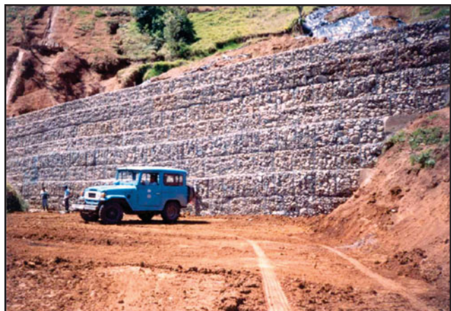
Foto 6.1. Muro de gaviones en la Vuelta del Queque
