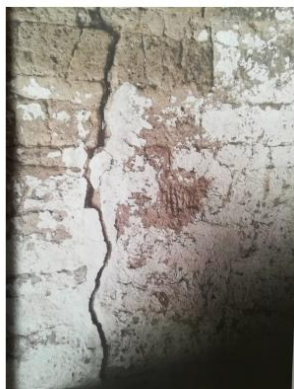
Ejemplos de casas dañadas en Pueblo Viejo, San Sebastián Huehuetenango. Estos tipos de daños no pueden ser reparados.
