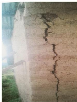
Ejemplos de casas dañadas en Pueblo Viejo, San Sebastián Huehuetenango. Estos tipos de daños no pueden ser reparados.
