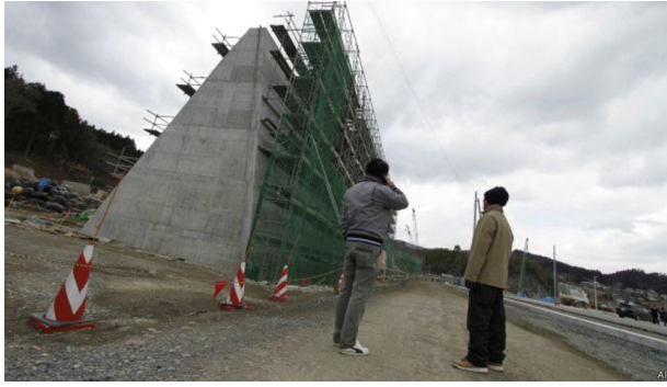
Foto: Víctor García, 2015, muro en construcción
