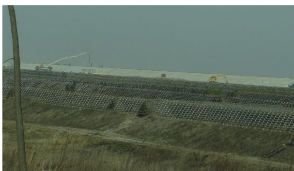
Foto: Victor García, 2015, muro en construcción
