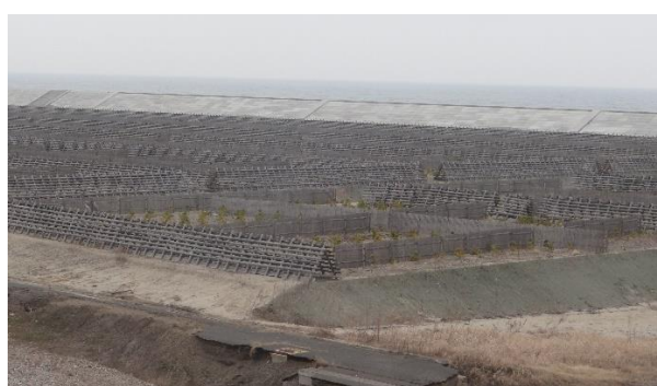
Foto: Victor García, 2015, muro en construcción
