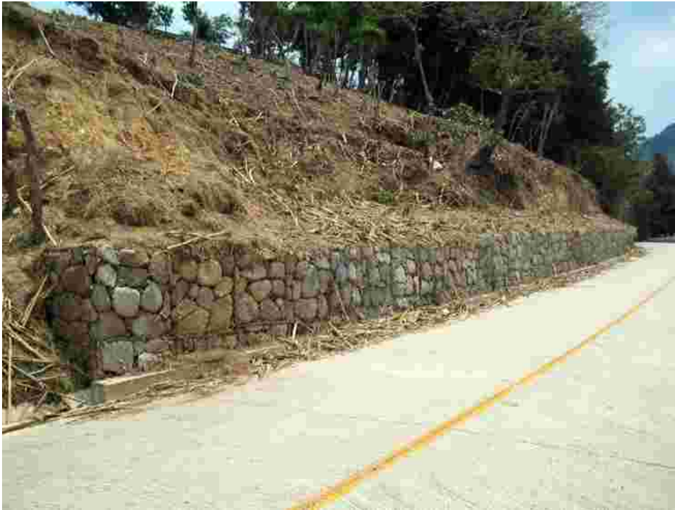
Gaviones de protección carretera Las Pilas, Cantón Río Chiquito, San Ignacio, Chalatenango (Foto: TRIFINIO/GTZ)
