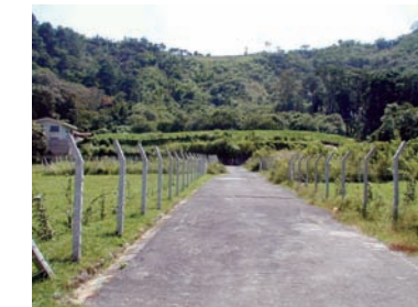
Las Colinas 4 años después del deslizamiento producido por terremoto del 2001 (Foto: Cilli Sobiech GTZ/TRIFINIO)
